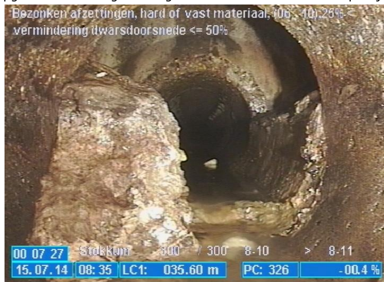
figuur 11 Beeld uit rioolinspectie met videocamera
