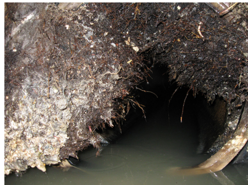
Het riool heeft een onweerstaanbare aantrekkingskracht op boomwortels door het vocht en de warmte. Op den duur kunnen dikke matten haarwortels het riool verstoppen.
