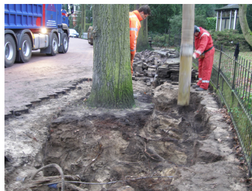
Het vergroten van de boomspiegel in combinatie met groeiplaatsverbetering door het wegzuigen van verdichte, schrale grond. De wortels worden hierdoor minimaal beschadigd.
