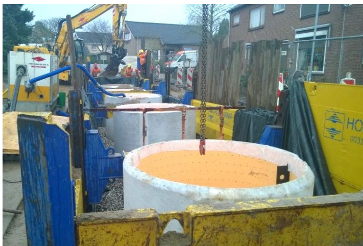
figuur 2 Afkoppelen en aanleg infiltratievoorziening in Stokkum
