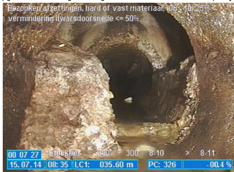
figuur 11 Beeld uit rioolinspectie met videocamera
