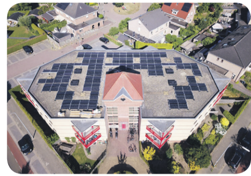
Zonnepanelen Diemse Zon! appartementengebouw Singel 64 Didam.
