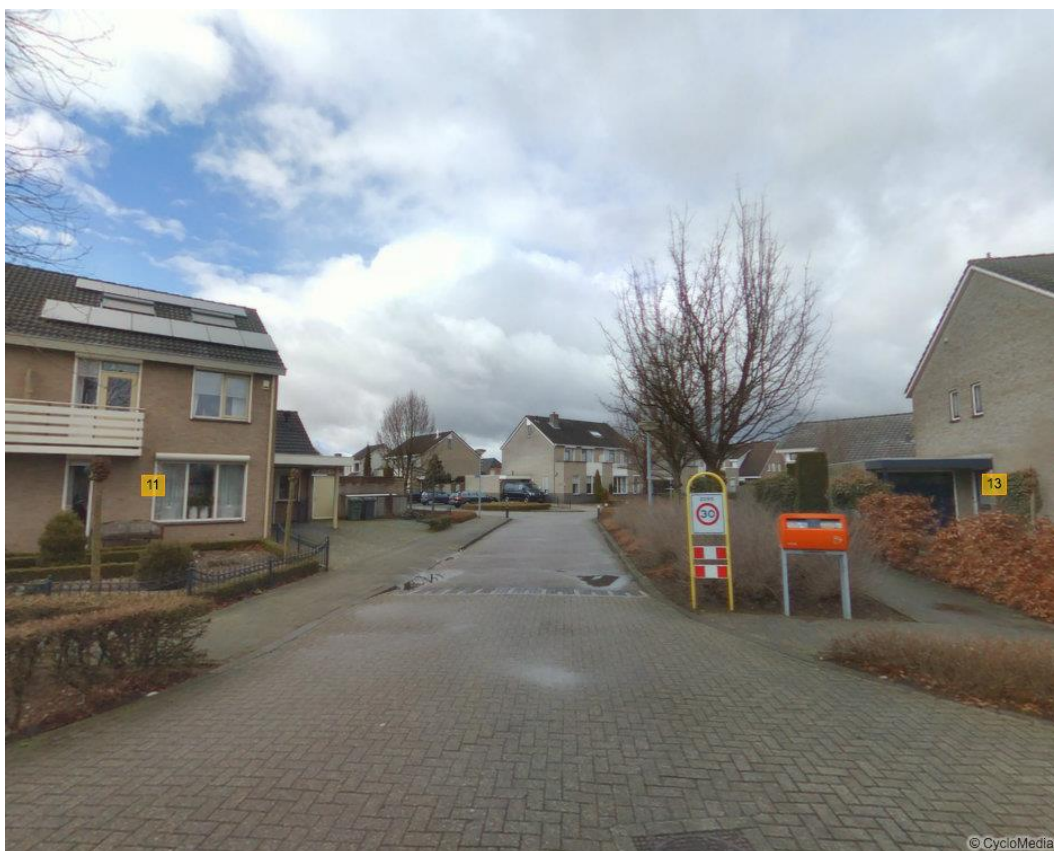
(voorbeeld zoneportaal aan één zijde van de weg geplaatst)
