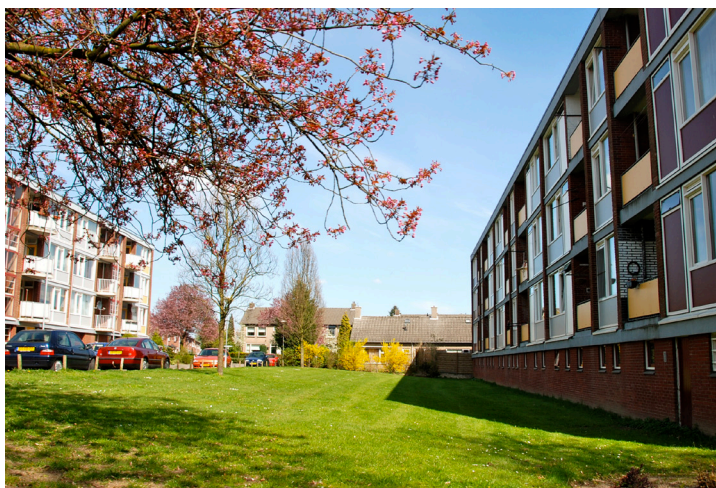
flats ten oosten van de Drieheuvelenweg
