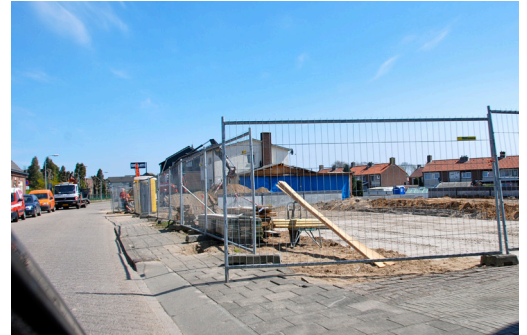
nieuwbouw aan de Lengelseweg deze weg is de verbinding van de Heksenpoort met de middeleeuwse stad en Huis Bergh
