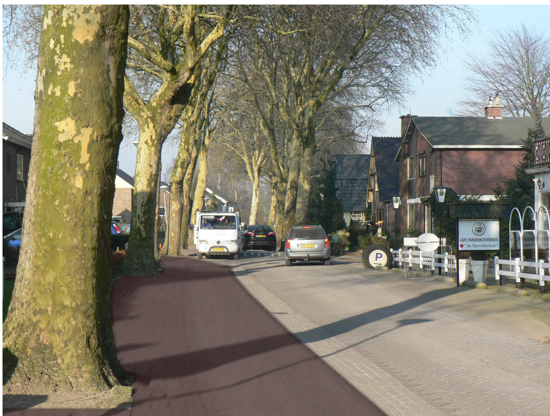
herbestrating van de St.Jansgildestraat waarbij de 'stoep' iets hoger wordt gelegd zodat de wortels van de platanen de straat niet meer opdrukken en er een duidelijker strook komt die voor de wandelaars is bestemd
