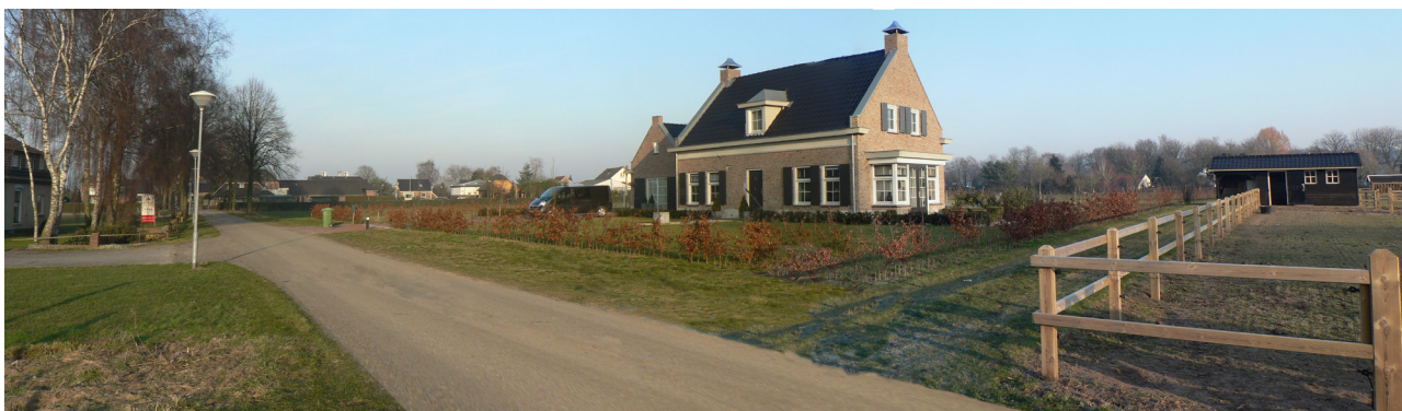
nieuwbouw aan de Den Hamweg, voorbeeld van een eenvoudige maar effectieve nieuwe landelijke erfbeplanting
