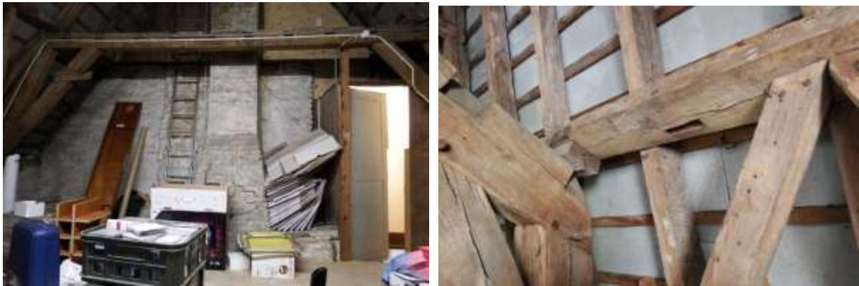
Afb. 32: Constructie op de zolder. Links de dekbalk van een juk met de uitsparingen voor kinderbinten en rechts hergebruikte onderdelen, herkenbaar aan de open oplegging van de een kinderbint en een ongebruikt pengat in de fliering
