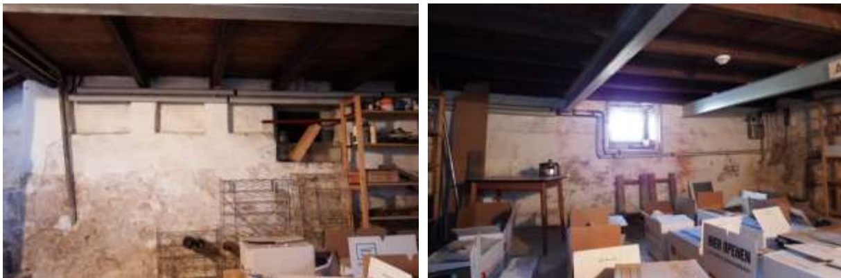
Afb. 27: Kelderruimte, links naar de voorgevel met het op de versnijding (ter hoogte van de onderzijde van het kelderluik) opgebouwde massieve metselwerk dat uitloopt in penanten als oplegging van de balklaag. Rechts een overzicht van de ruimte naar de linker zijgevel
