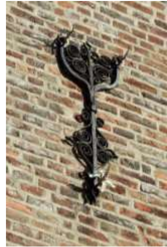
Afb. 21: Rijk bewerkt anker in de rechter topgevel met uitgesmede bloemen.
