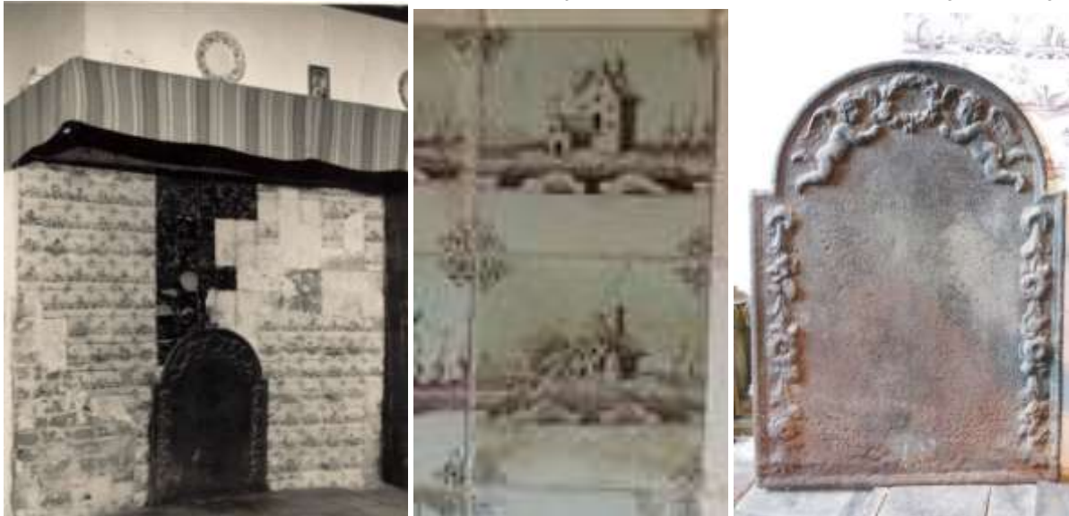
Afb. 28: Schouwboezem met de betegelde achterwand. Links een overzichtsfoto gedateerd 1956, in het midden een detail van de tegels voorzien van een landschap en hoekornamenten en rechts de haardplaat.
