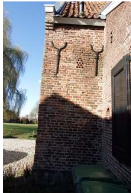
Afb. 6: Achtergevel van het huis en de zijgevel van de aanbouw beiden uitgevoerd in kruisverband.
