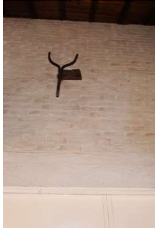
Afb. 19: Nieuw metselwerk ter plaatse van de aansluiting van het voormalige achterhuis. In het metselwerk is een van de moerbinten uit de middelste kamer met de verankering zichtbaar.
