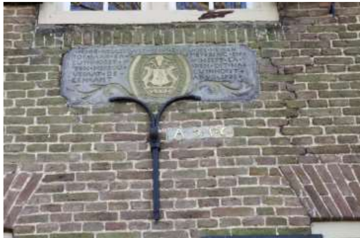
Afb. 13: Memoriesteen in de linker zijgevel die de herbouw in 1788 aangeeft; daaronder de jaartalsteen.
