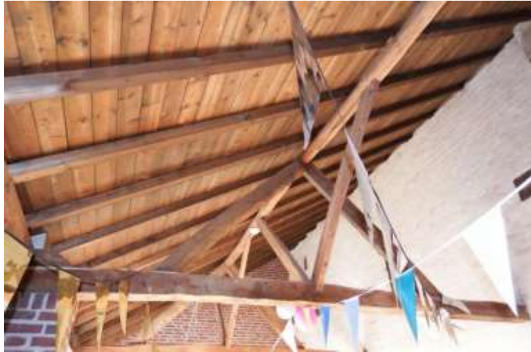
Afb. 29: Dakconstructie in de ongedeelde ruimte met hergebruikte elementen. Rechts het vertinde metselwerk in standaard dik-formaat. In de bovenhoek nog juist de aanzet van het gevelmetselwerk zichtbaar.
