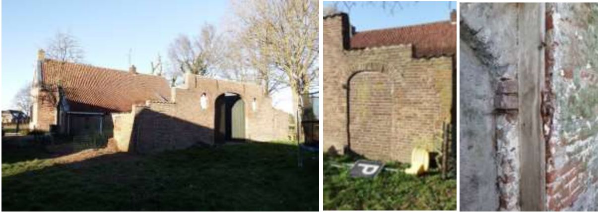
Afb. 26: Symmetrisch ingedeelde achtergevel van het voormalige achterhuis (links), een dichtgemetselde staldeur met een uitgehakte steensponning en een duim (midden) waarvan op de rechter foto de verankering zichtbaar is.
