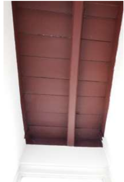
Afb. 17: Plafond in de gang achter de entree. Aan weerszijden van de zijmuren bevinden zicht moer- en kinderbinten.
