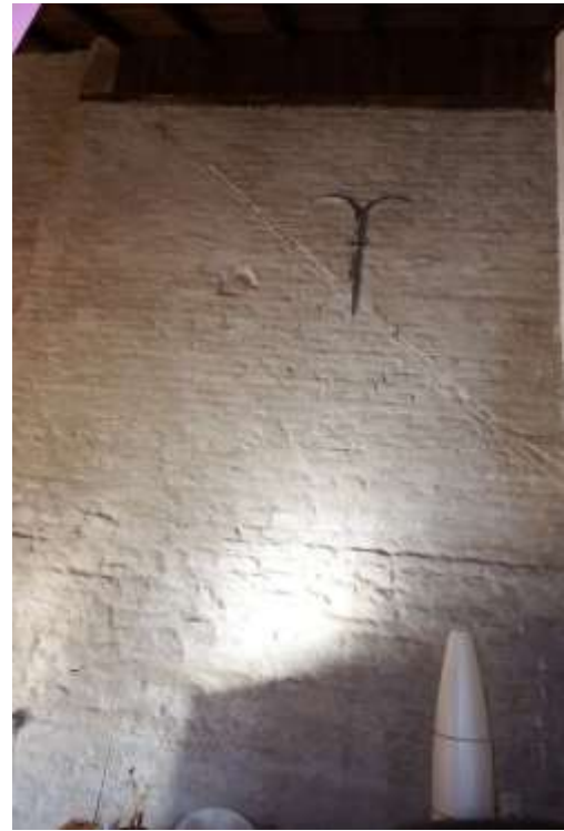
Afb. 14: Achtergevel van het huis waarin links boven de beëindiging van het metselwerk zichtbaar is.
