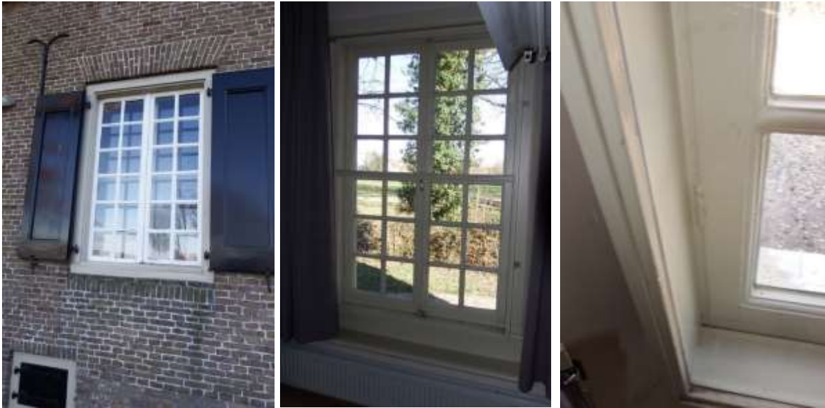
Afb. 23: Het venster in de voorgevel in de opkamer. Links aan de buitenzijde, in het midden de binnenzijde met voorzetraam en rechts een detail van het oorspronkelijke raam met de aansluiting van een roede op het raamhout.
