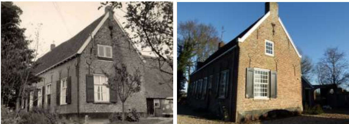
Afb. 24: rechter zijgevel voor (links) en na de restauratie (rechts). Behalve dat de vensterindeling is gewijzigd is het venster in de topgevel versmald tot een 9-ruits venster. Ook de luiken hebben een gewijzigde vorm gekregen.
