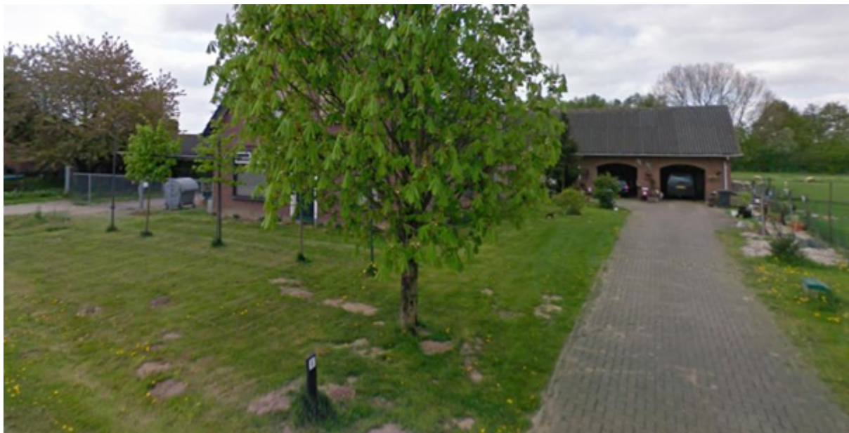
Bedrijfswoning met garage/berging en 'schone' oprit d.d. 2012
