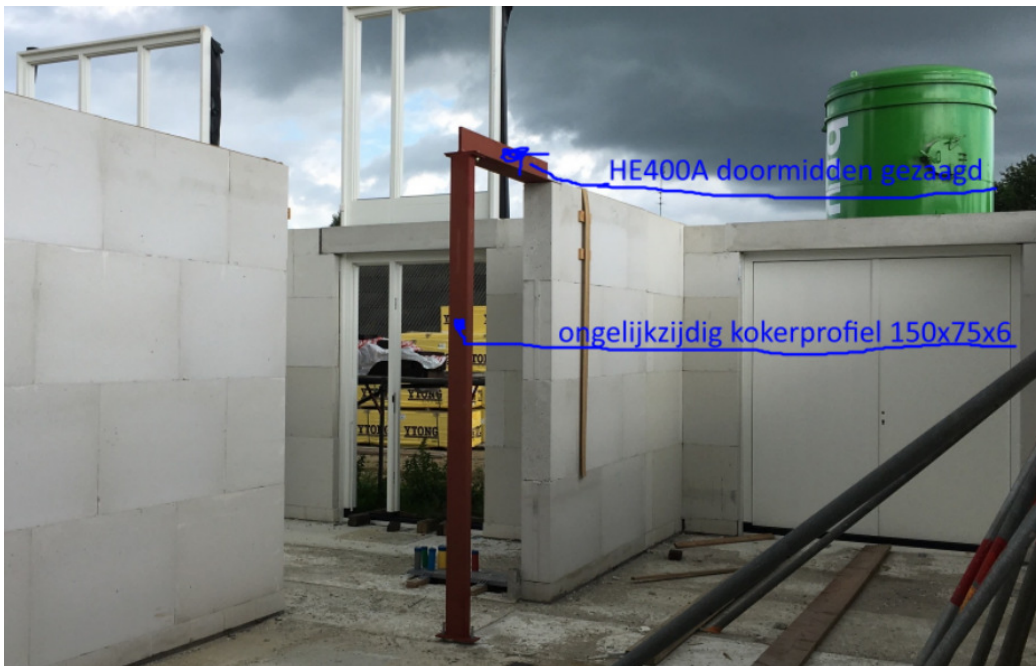
Overzicht latei met kolom boven loopdeur pos 2
