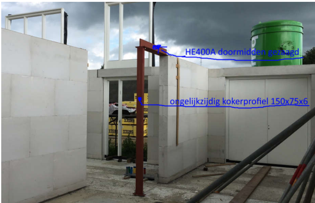
Overzicht latei met kolom boven loopdeur pos 2
