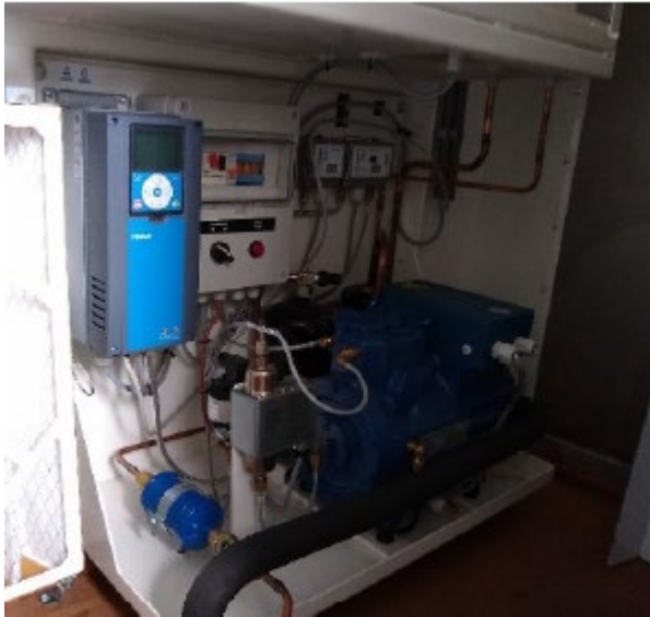
Figuur 9 – Batterijkoelsysteem (Links batterijventilatoren, rechts de koelunit)
