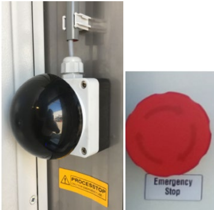
Figuur 19 – Processtop in omvormer-ruimte (boven) en batterij-ruimte (beneden)
