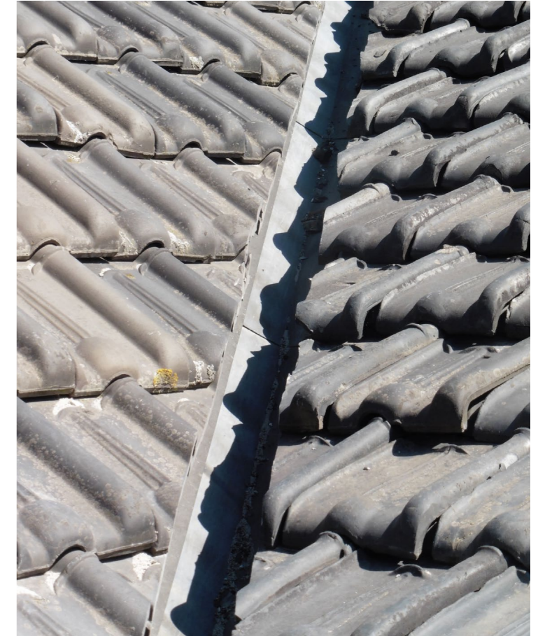
Afbeelding 4: Voorbeeld van een vernieuwde zinken bekleding in een kilgoot. Zichtbaar zijn de diverse stukken zink waaruit de kilgootbekleding is opgebouwd.
