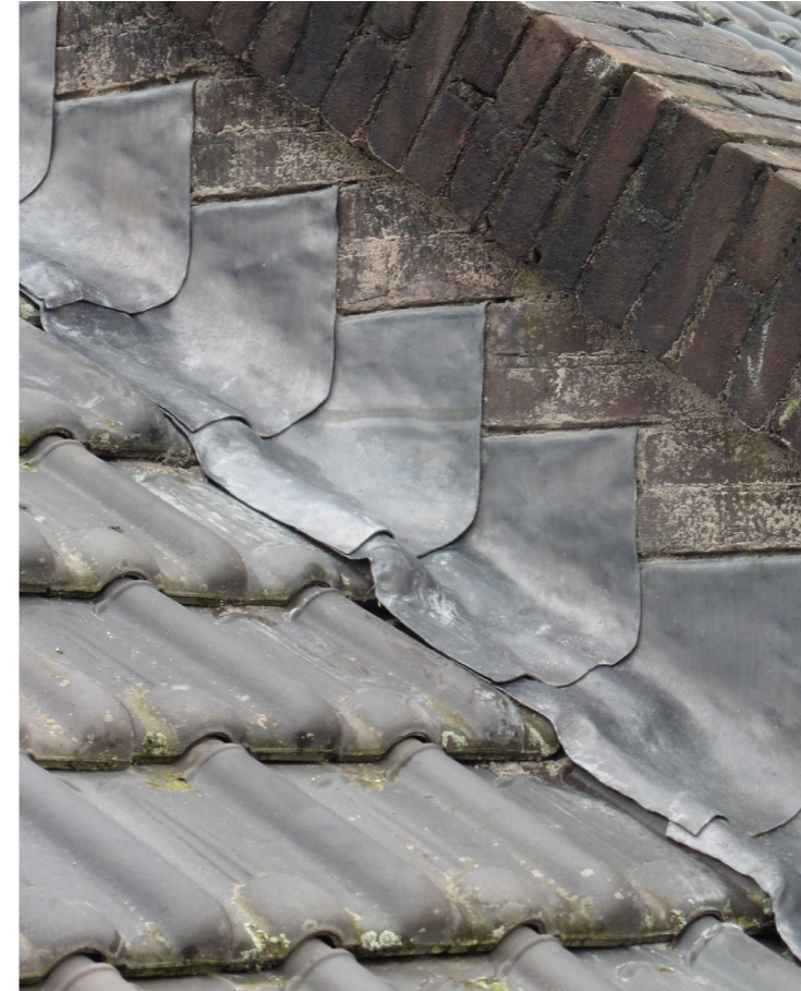
Afbeelding 3: Voorbeeld van vernieuwde loodloketten ter plaatse van opgaand metselwerk. De loketten zijn dakpansgewijs aangebracht om een correcte afwatering te verkrijgen.
