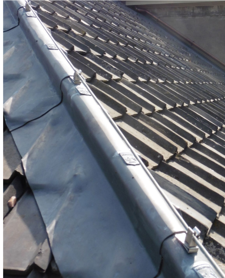
Afbeelding 2: Voorbeeld van een vernieuwde hoekkeperafdekking met overlappende loodafdekkingen. De nagels waarmee het lood is vastgezet zijn afgewerkt met trotseerloodjes.
