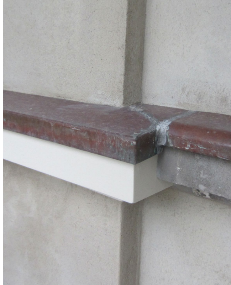
Afbeelding 1: Voorbeeld van een vernieuwde koperen afdekking ter plaatse van een gevellijst, waarbij de naden zijn gesoldeerd.
