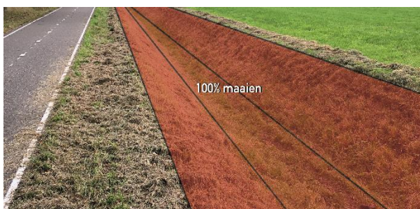
Figuur 16: de afvoerende sloten (en zaksloten) dienen volledig gemaaid te worden
