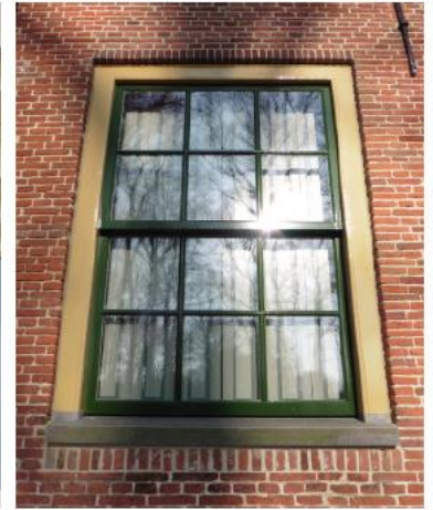
Afbeelding 4: Voorbeeld van nieuw schilderwerk op bestaand kozijn- en raamhout, waarbij de kleurstelling naar voren kwam door kleurhistorisch onderzoek.
