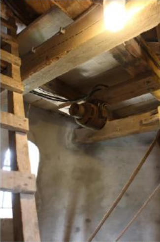
Een groot deel van de balkkoppen werden polymeerchemisch hersteld.
