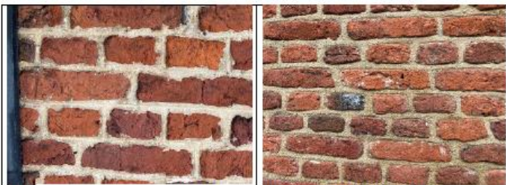
Oorspronkelijk voegwerk 1609 oostgevel
