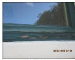
Ondeugdelijke verflagen 1/3m het kale hout.
