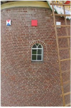
In de steigergaten op kapzolder allemaal gekleurde plankjes. Dit was in 1951 ook al aanwezig blijkt uit de opmetingen van Sipman. Een bijzonder bouwdetail.
