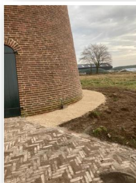
Molenromp na afvoegen en het aanbrengen van een verharding rondom de molen.
