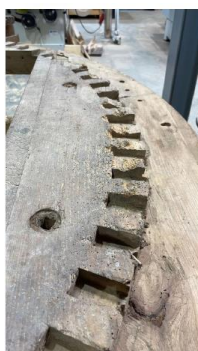
Voor het herstel werden de velgstukken en de plooiën overgebracht naar de werkplaats
