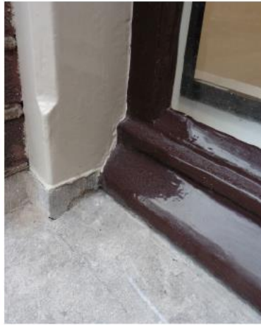
Afbeelding 2: Voorbeeld van nieuw schilderwerk op bestaand kozijn- en raamhout waarbij ook de stopverfbesetting is vernieuwd en overschilderd. De bordeauxrode kleur kwam uit kleurhistorisch onderzoek naar voren.
