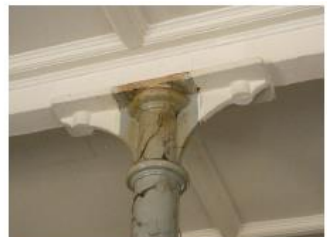
Afb. 33: Detail van de kop van de gietijzeren kolom.
