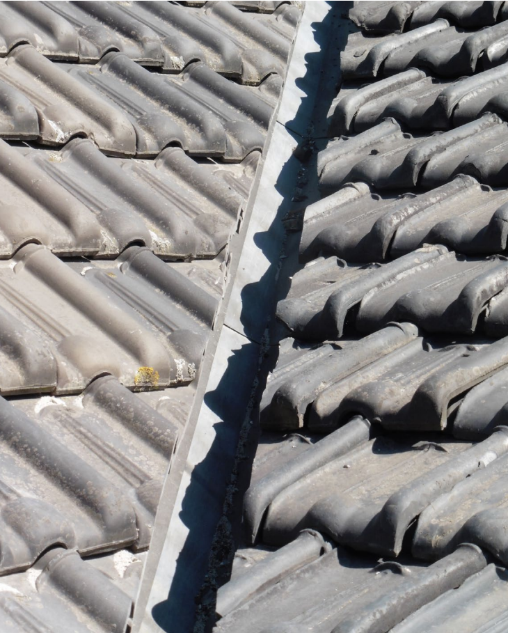
Afbeelding 4: Voorbeeld van een vernieuwde zinken bekleding in een kilgoot. Zichtbaar zijn de diverse stukken zink waaruit de kilgootbekleding is opgebouwd.
