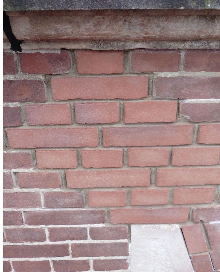
Afbeelding 2: Voorbeeld van een gedeelte ingeboet metselwerk met een bijpassende baksteen en conform het bestaande metselverband.
