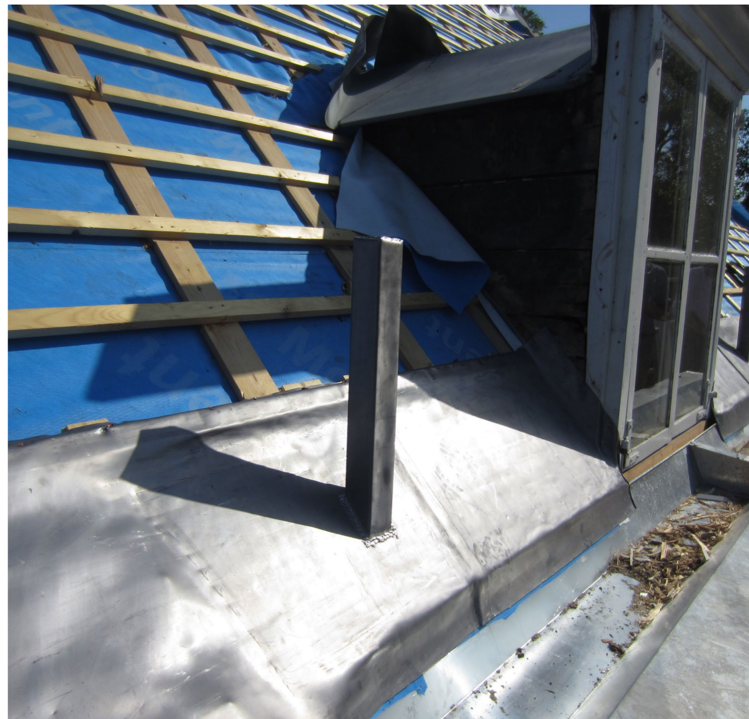
Afbeelding 8: een ander voorbeeld waarbij het dakvlak aan de buitenzijde is voorzien van isolatie, waarbij de verhoging van het dakpakket nauwelijks gevolgen heeft gehad voor de aansluitingen met de goot en dakkapel.
