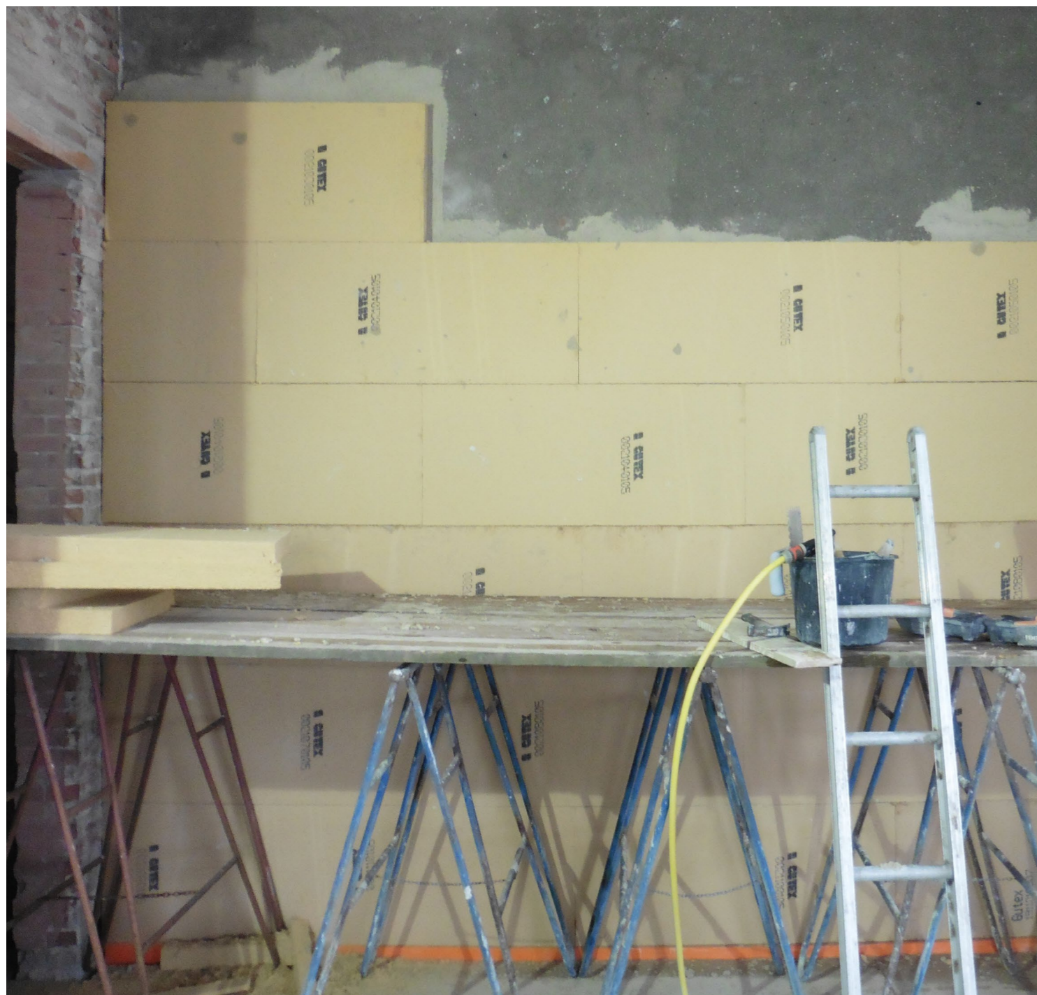
Afbeelding 4: een voorbeeld van een isolatie principe volgens het capillair actieve systeem (Gutex). De platen zijn hierbij rechtstreeks op de metselwerk buitengevel aangebracht.
