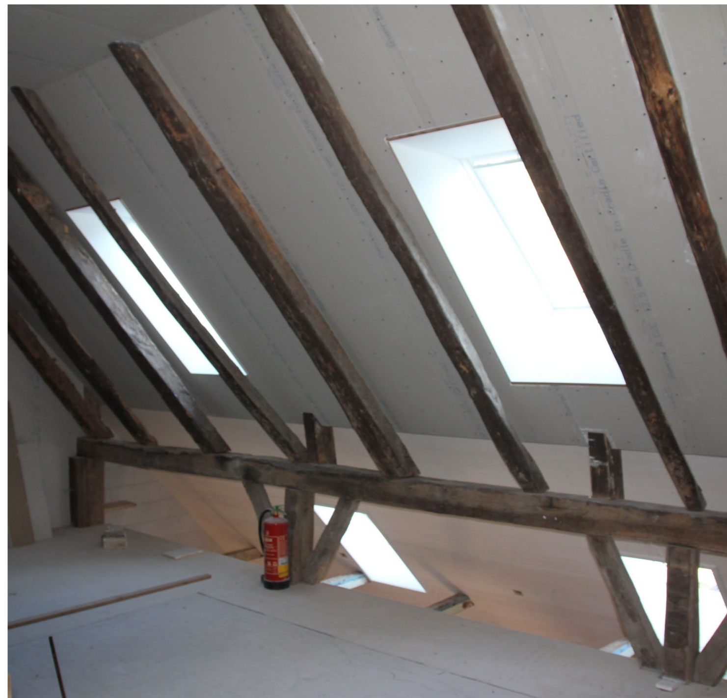
Afbeelding 12: ander voorbeeld van een houten kapconstructie waarbij er tussen de kasporen isolatie is aangebracht en het geheel is afgewerkt met gipsplaat. De monumentale waarden van de kapconstructie blijven hierdoor zichtbaar.
