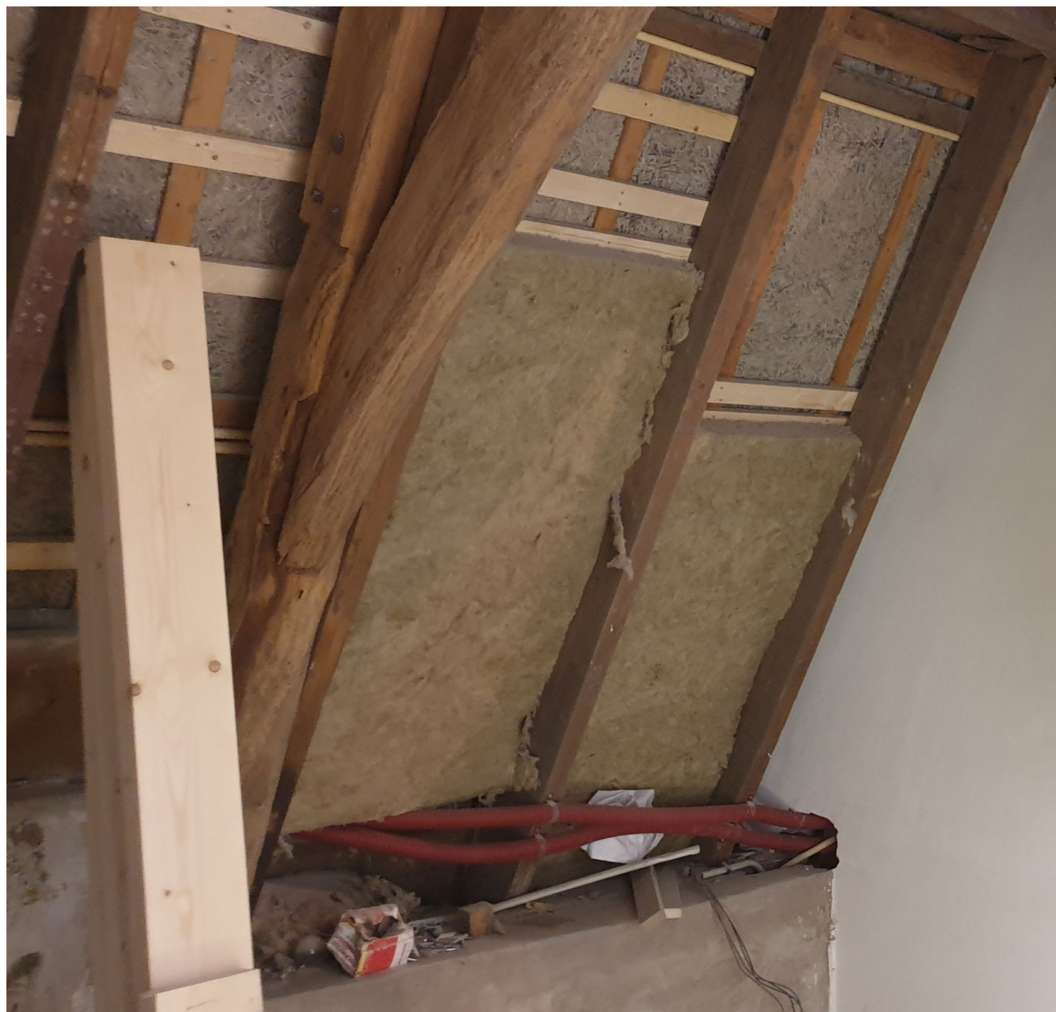
Afbeelding 10: voorbeeld van het na isoleren dan de kapconstructie aan de binnenzijde, tussen de bestaande kasporen, zodat het monumentale aanzicht van de kapconstructie in het zicht blijft. (in een eerder stadium was hier al een houtwolcementplaat op de kasporen aangebracht).
