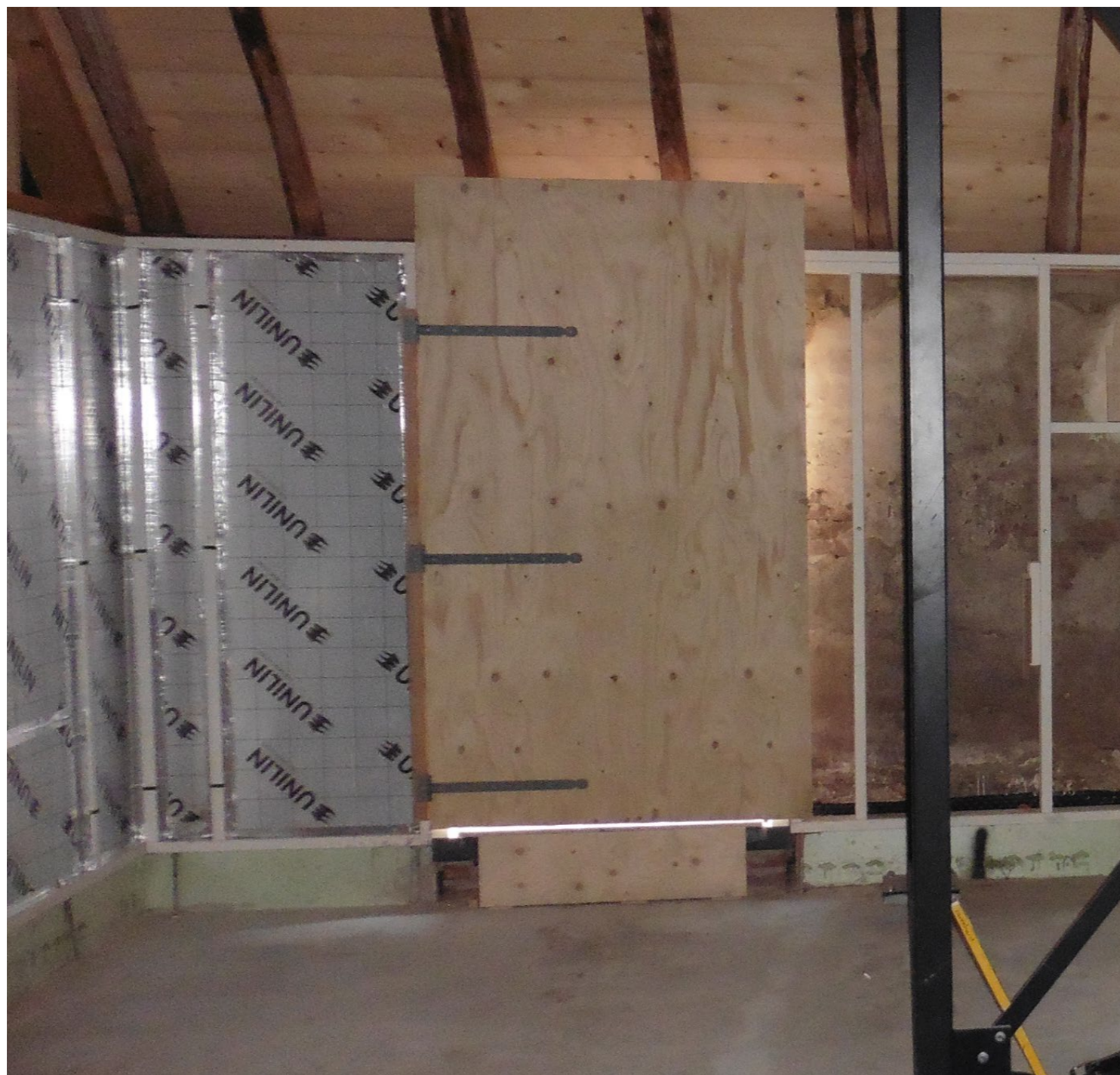
Afbeelding 1: Houten stijl- en regelwerk achter de bestaande gevels geplaatst en voorzien van een PIR isolatieplaat.
