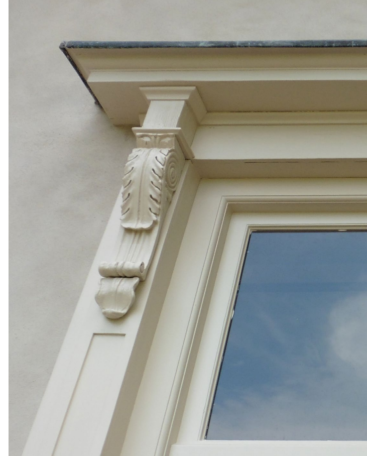
Afbeelding 3: Voorbeeld van nieuw schilderwerk op een houten kozijn en architraaflijst. Hierbij is het belangrijk dat details zoals houtsnijwerk niet verloren gaan bij het aanbrengen van het nieuwe verfsysteem.
