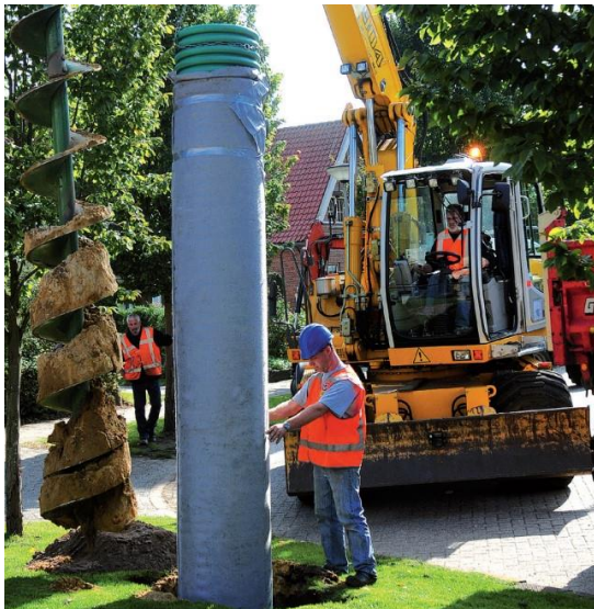
Foto grondboring met infiltratie
