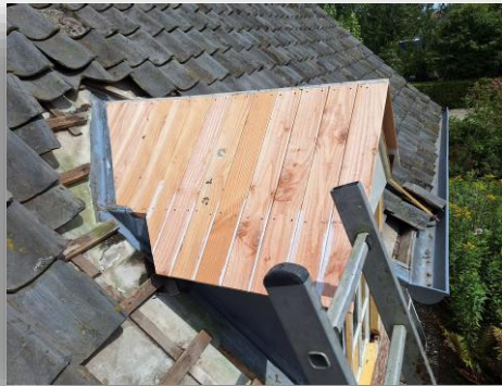
Pastoor van Sonsbeeckstraat 48a Stokkum (herstel dakkapel met zinken afdekking)
