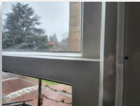
Bovendorpsstraat 7a Zeddam (achterzetbeglazing)
