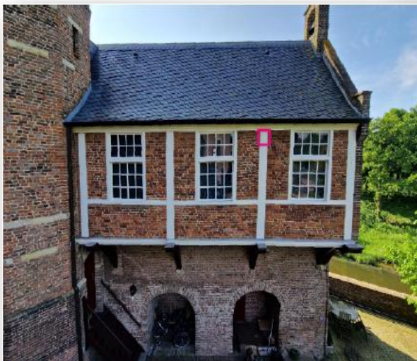
Figuur 42. Noordgevel van de kapel. Locatie van kleurtrap op een van de houten balken van het vakwerk.
