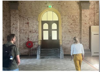
Bestaande houtkleur interieur deuren
