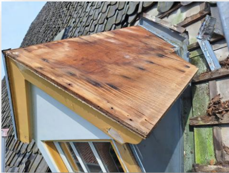
Pastoor van Sonsbeeckstraat 48a Stokkum (herstel dakkapel met zinken afdekking)
