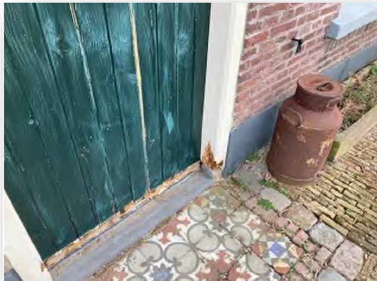
Manhorstweg 12 Didam (houtrotherstel)
