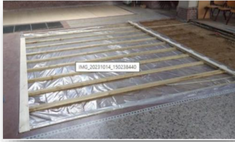
Smallestraat 35a Nieuw-Dijk (renovatie kerkvloer)
