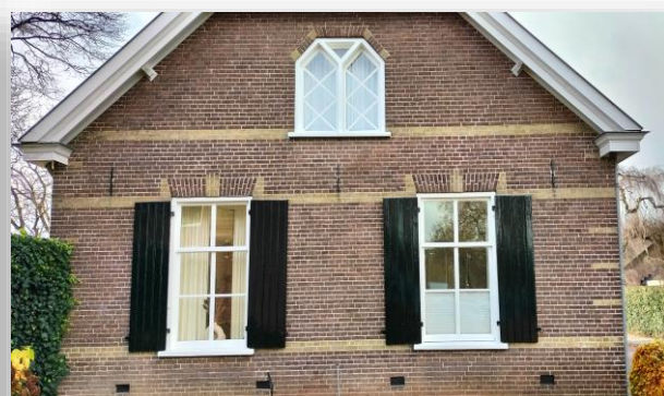
Deken Reuvekamplaan 3 Didam (schilderwerkzaamheden)
