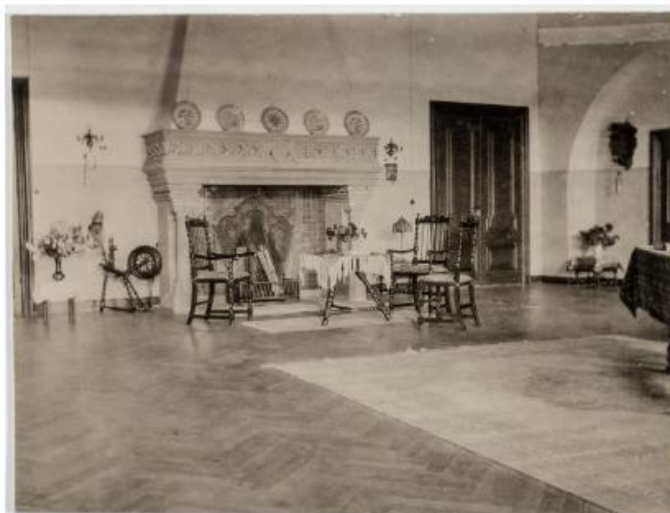
Figuur 4. Foto van een van de zalen in het kasteel voor de brand. Heek-van Wulfften Palthe, A. van – Fotograaf. Datering: 1915. Bron: Beeldbank Rijksdienst voor het Cultureel Erfgoed, documentnummer OF-09149.
