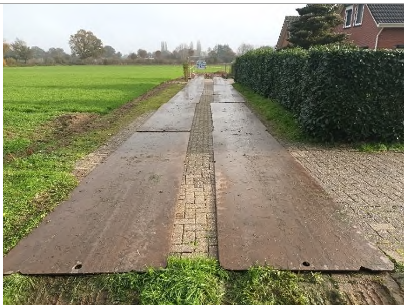
Rijplatenbaan ter bescherming van het straatwerk
