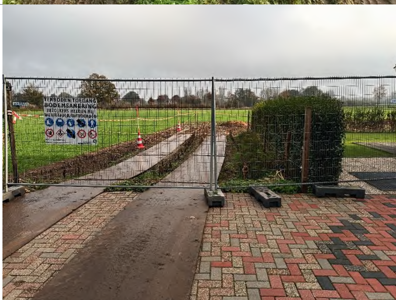
Toegangspoort naar saneringslocatie
